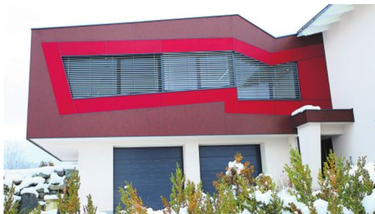
Zubau mit mehrfach geknicktem Dach.
